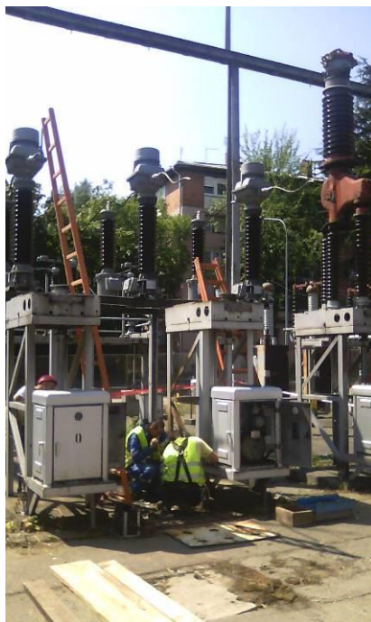
SLIKA 4 – DEMONTAŽA MALOULJNOG 110 KV PREKIDAČA
