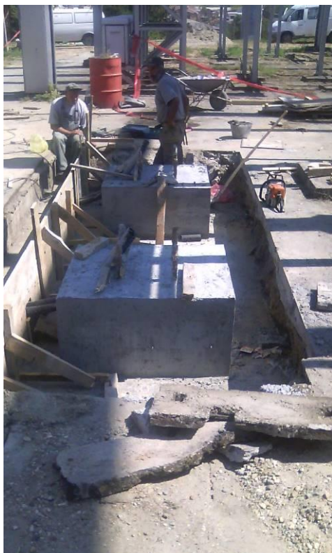
SLIKA 5 – IZRADA TEMELJA ZA NOVI 110 KV PREKIDAČ
